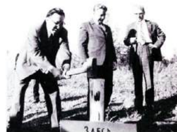
Г.И. Чиряев забивает колышек на месте строительства Нерюнгринского угольного разреза. 6 августа 1974 г.
