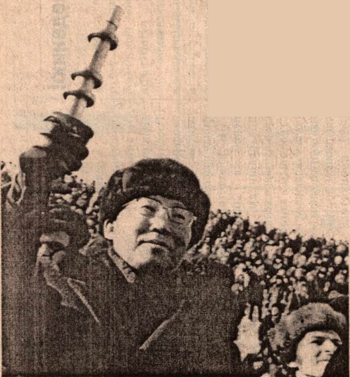
Торжественный митинг, посвященный укладке "золотого звена" на разрезе "Якутский" 2 ноября 1976г. Первый секретарь Якутского обкома КПСС Г.И.Чиряев.
