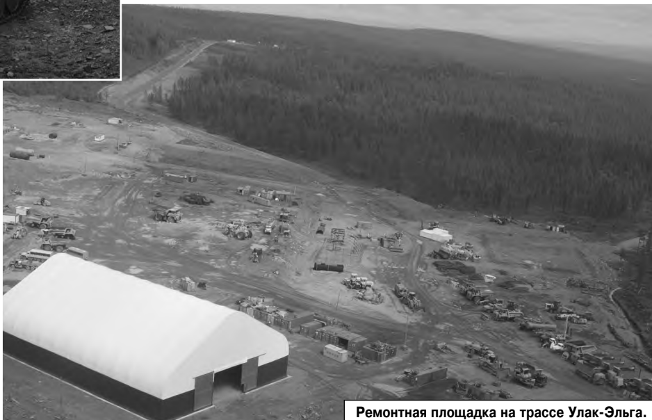
Ремонтная площадка на трассе Улак-Эльга.
