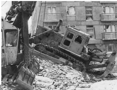
Техника УМС-12 - на строительстве дома по пр. Геологов.
