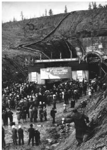
Сбойка южного и северного порталов тоннеля Нагорный. 10 сентября 1977 г.
