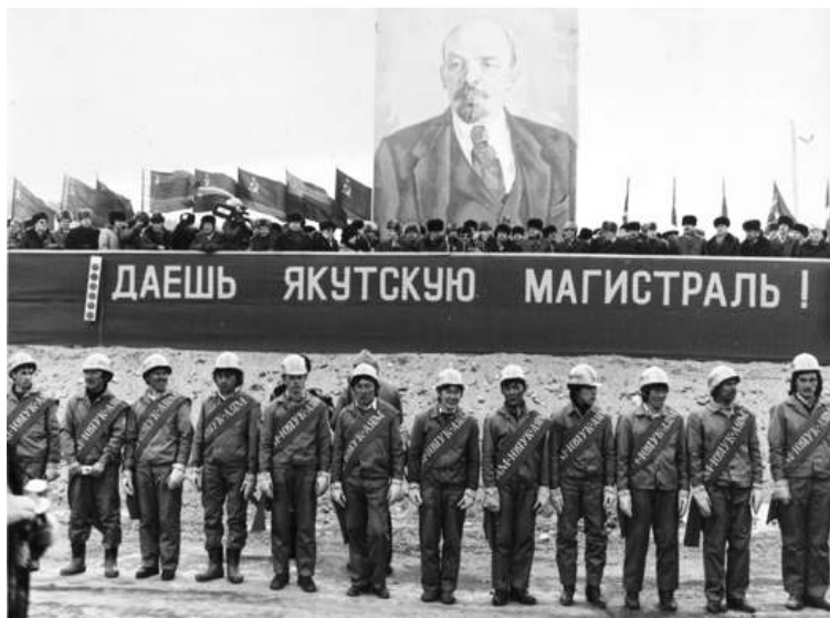
Отряд «Якутский комсомолец» на торжественном митинге, посвященном укладке «серебряного» звена АЯМа, положившего начало строительству железнодорожной магистрали Беркамит-Томмот-Якутск. 11 апреля 1985 г.
