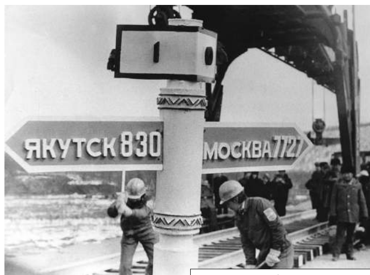
Укладка «серебряного» звена на строительстве железнодорожного АЯМа. 11 апреля 1985 г.
