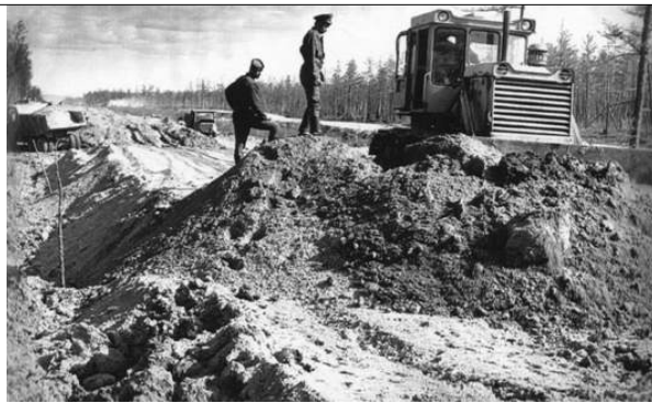
Возведение полотна дороги воинами-железнодорожниками на участке Ургал-Тында.
