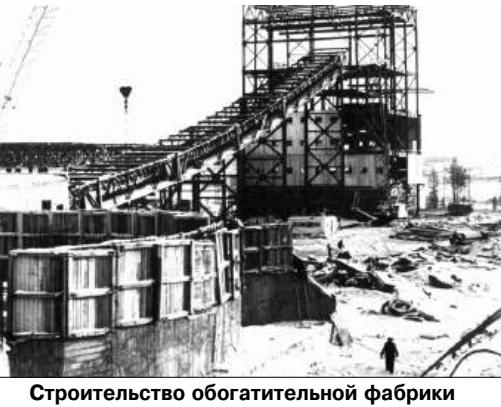
Строительство обогатительной фабрики
