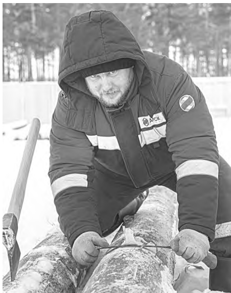
За ошкуривкой энергогеса электромонтёр по ремонту воздушных линий Максим Арефьев.
