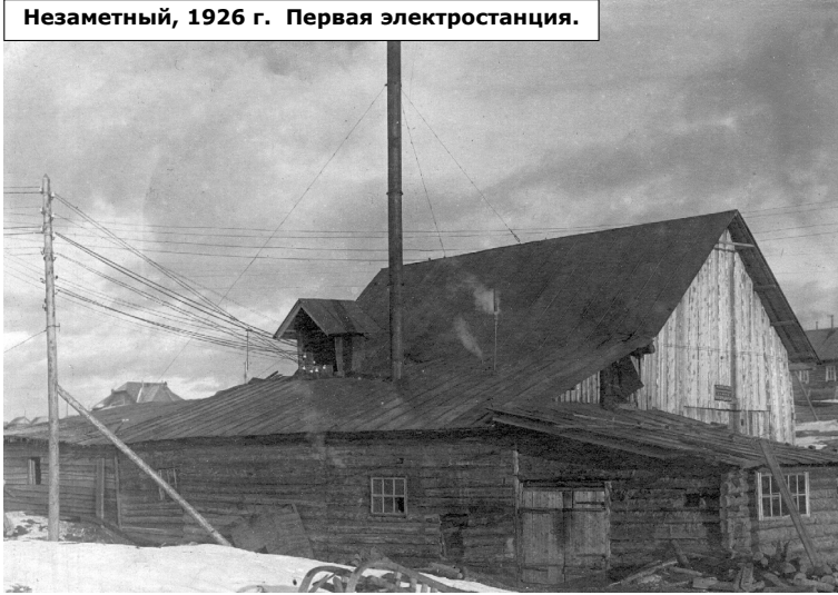
Незаметный, 1926 г. Первая электростанция.
