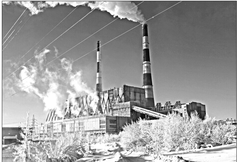
Станция НГРЭС. / фото: НГРЭС
