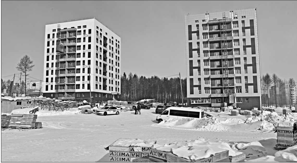
Жилищное строительство в Якутии по итогам 2023 года достигло рекордных для региона показателей. В Нерюнгри полным ходом идет строительство квартала «Р». / ФОТО: ЮРИЙ КОКОВИН
