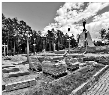
Полным ходом идет ремонт подножия стелы «Ника». / ФОТО: ЕЛЕНА ПРОСКУРИНА
