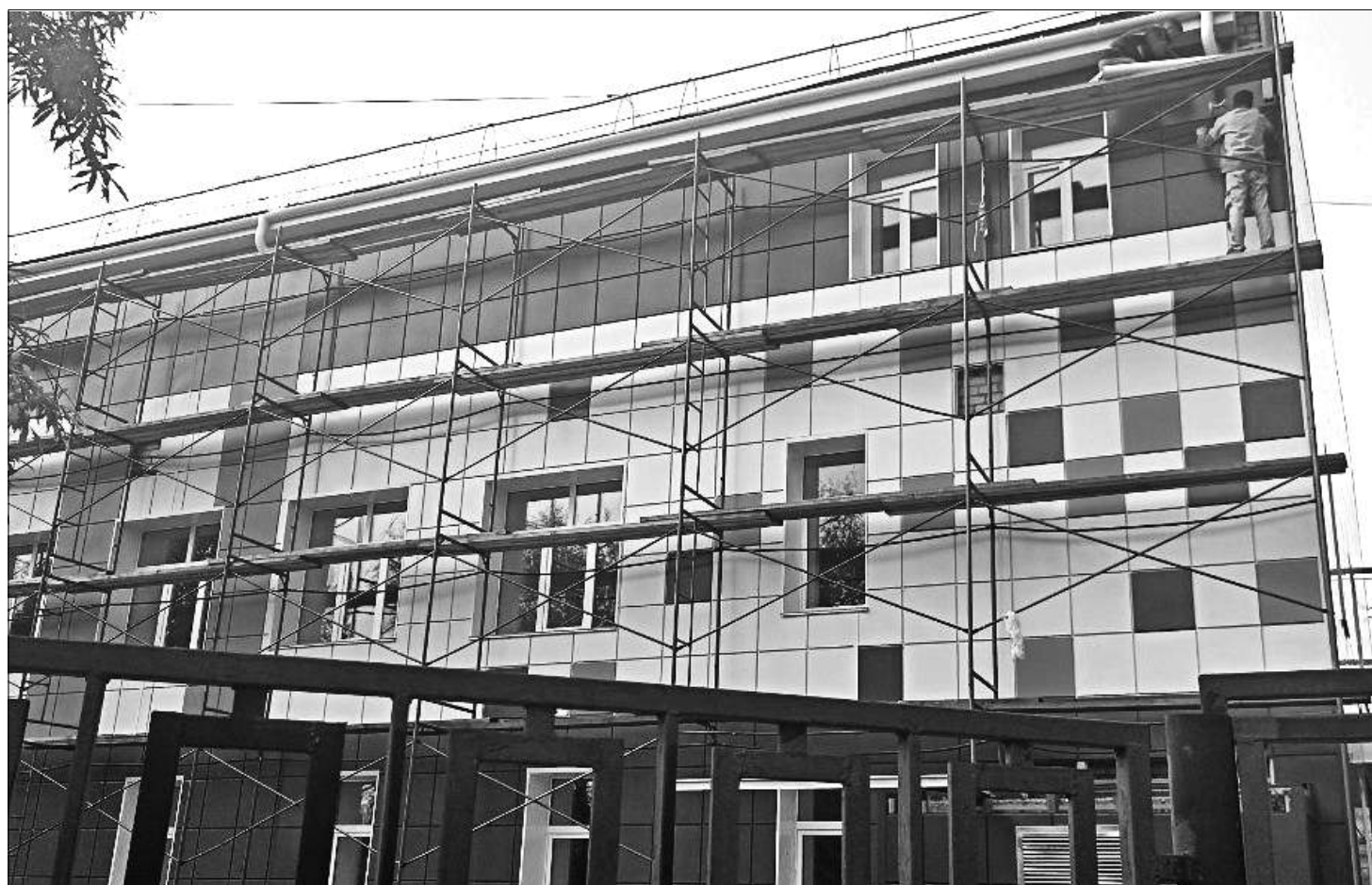
Ремонт СОШ № 22 в Беркаките. / ФОТО: НЕРЮНГРИНСКАЯ РАЙОННАЯ АДМИНИСТРАЦИЯ
