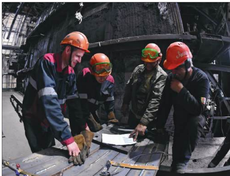
Энергетики продолжают ремонт энергоблока. / ФОТО: ЮРИЙ КОКОВИН
