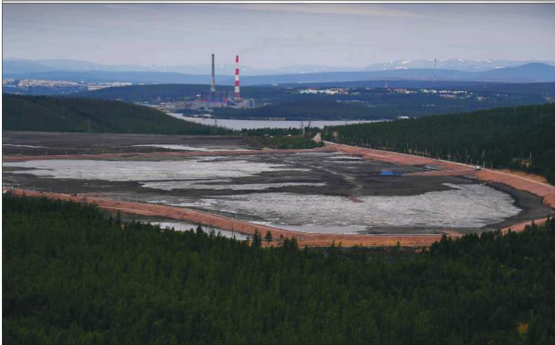
📷 Завершен первый этап инвестпроекта по наращиванию ограждающей дамбы шлакозолоотвала с целью улучшения экологической безопасности района. / ФОТО: ЮРИЙ КОКОВИН
